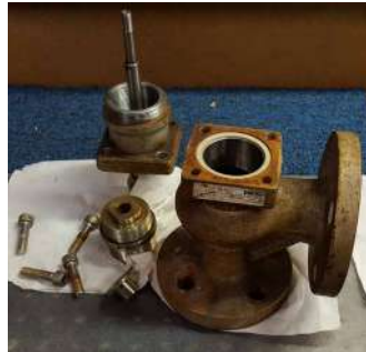
Étape 2 Démontage et vérification de la faisabilité de la remise en état et du retarage
